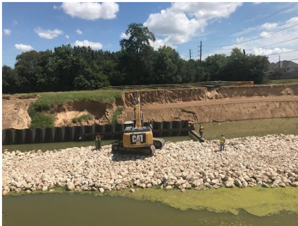
Phase 6 – Site 316 Pinning Sheet Piles
